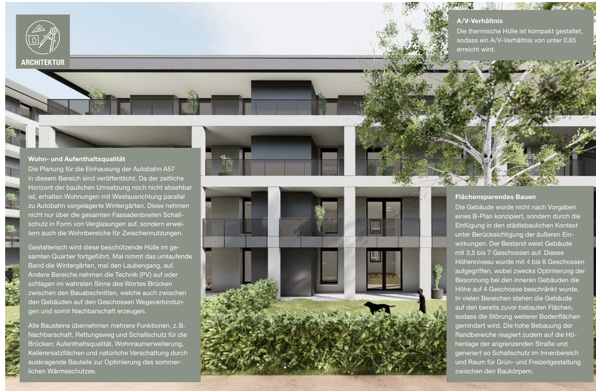
Abbildung: Neubau – Quartier Horrem Quartiersauftakt Haus 1.4
