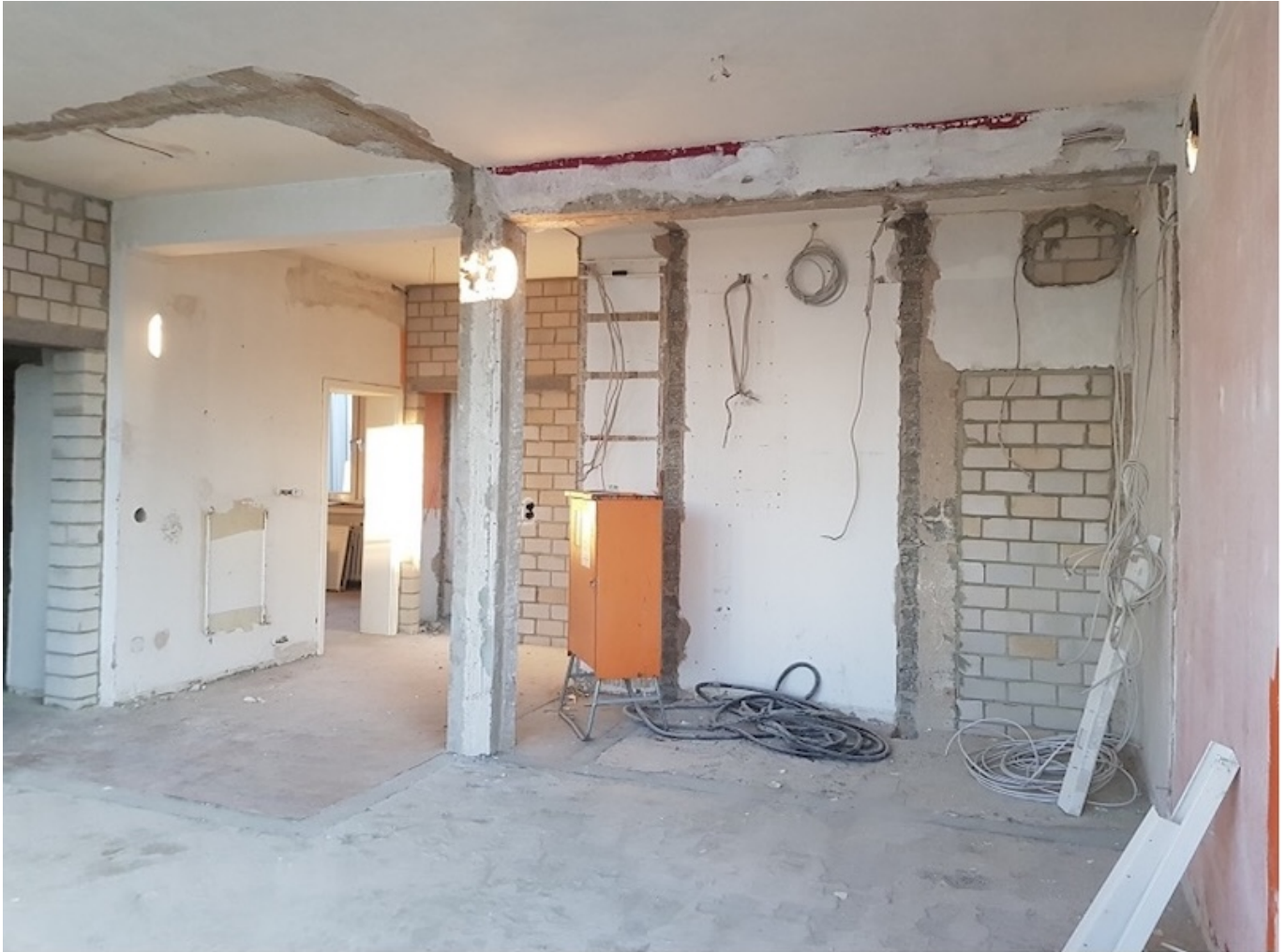
Noch im Umbau: Der künftige Gemeinschaftsraum der Baugenossenschaft Dormagen wird Treffpunkt für Mitglieder und ein Ort für gemeinsame Ideen und Projekte sein. © Baugenossenschaft Dormagen eG
