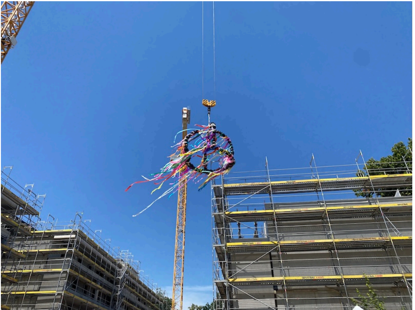
Vor strahlend blauem Himmel wurde die Richtkrone über dem ersten Bauabschnitt aufgezogen – ein Symbol für Fortschritt, Gemeinschaft und Zuversicht. © Foto: Anabell Weinen, Baugenossenschaft Dormagen eG
