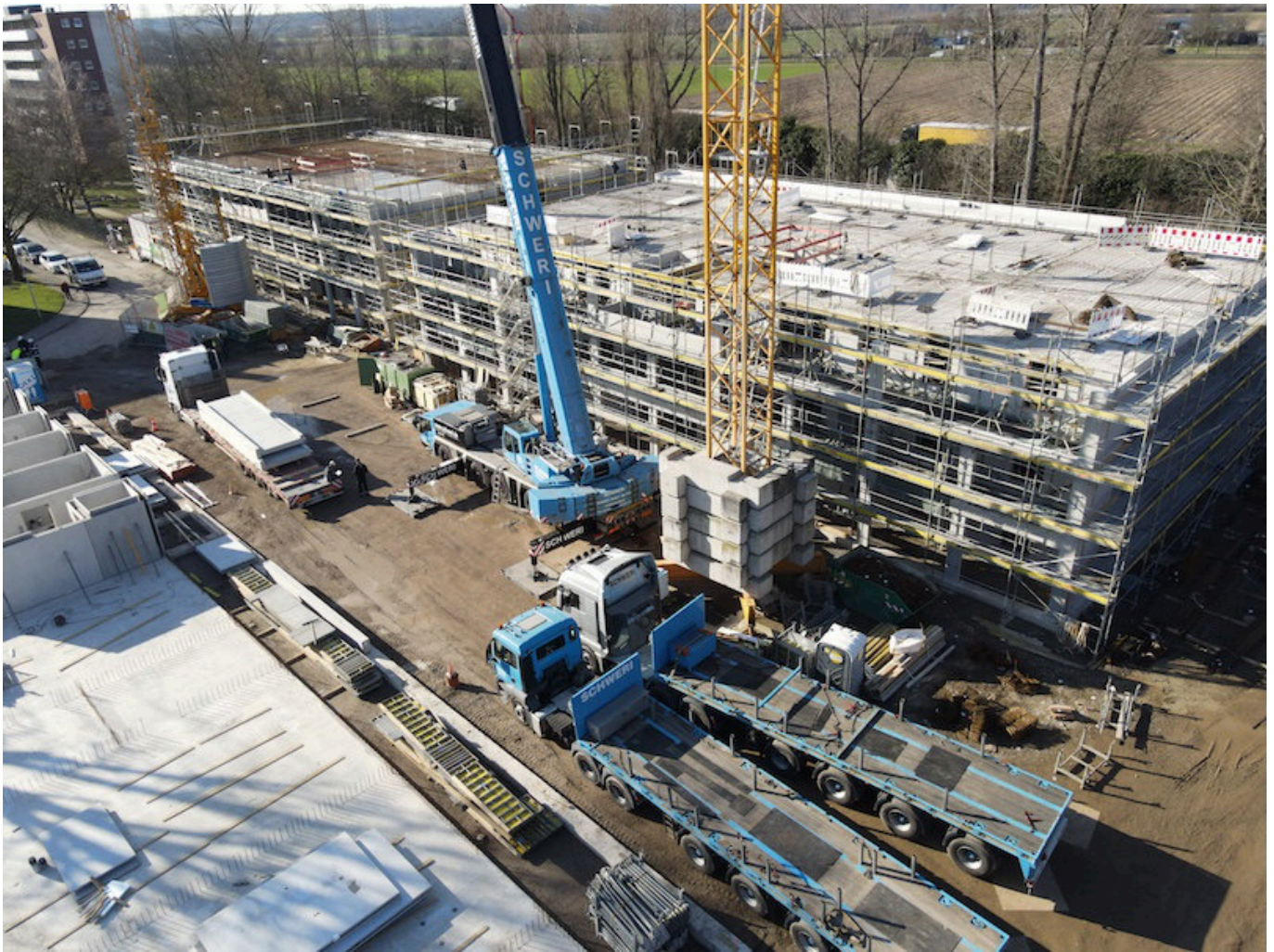
Die Baustelle des neuen Stadtquartiers Dormagen-Horrem im Frühjahr 2026. Das Projekt steht für den genossenschaftlichen Anspruch, Wohnraum verantwortungsvoll zu entwickeln und dabei die Interessen der Mitglieder langfristig im Blick zu behalten. © Baugenossenschaft Dormagen eG
