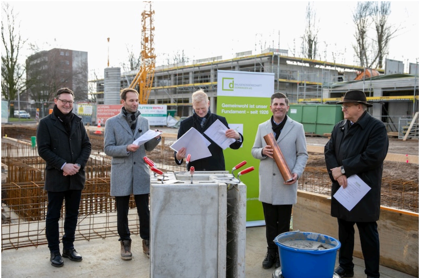
Bei der Grundsteinlegung am Kastanienweg (v. l. n. r.): Paul Jarosch, Leiter Prozessmanagement bei der Schmale Architekten GmbH, Dipl.-Ing. Michael Müller, Leiter Projektentwicklung der Schmale Architekten GmbH, Martin Klemmer, technischer Vorstand der Baugenossenschaft Dormagen eG, Christian van Kan, kaufmännischer Vorstand der Baugenossenschaft Dormagen eG, sowie Moderator Nikolaus Zumbusch von der BRANDCONTRAST GmbH beim Befüllen der Zeitkapsel. © Foto: Sharon Nathan, Baugenossenschaft Dormagen eG
