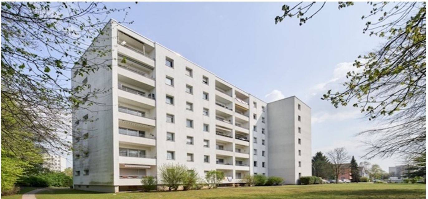
Das Wohngebäude Am Hagedorn 26 bleibt erhalten und wird im Zuge umfassender Maßnahmen modernisiert, um Wohnqualität und Barrierefreiheit nachhaltig zu verbessern. © Baugenossenschaft Dormagen eG
